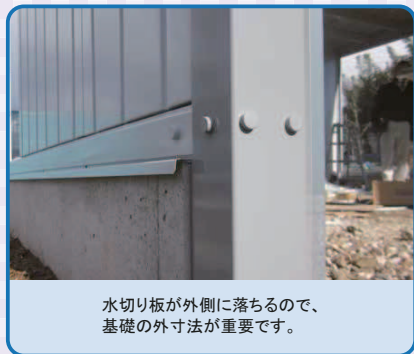
基礎天より400mmになるよう打設をお願い致します。(高基礎仕様は基礎天より700mm) ※製品荷重が中柱に掛ります。
